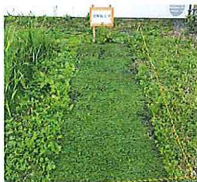
（クラピアシートキャップ工法）
