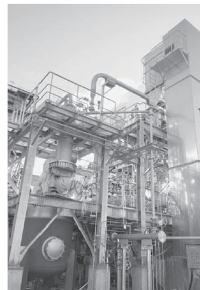
川崎工場に建設したパイロットプラントで研究を進める
