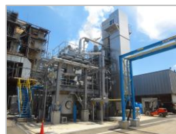
パイロットプラント (水蒸気爆砕・酵素糖化・発酵施設、ATJ施設) 三友グループ川崎地区に設置
