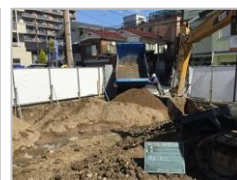
現地工事(埋め戻し)
