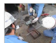
電気工具の取り扱い
