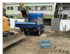
現地工事(掘削・搬出)
