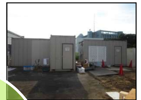
PCB汚染拡散対策用 移動式密閉作業室
